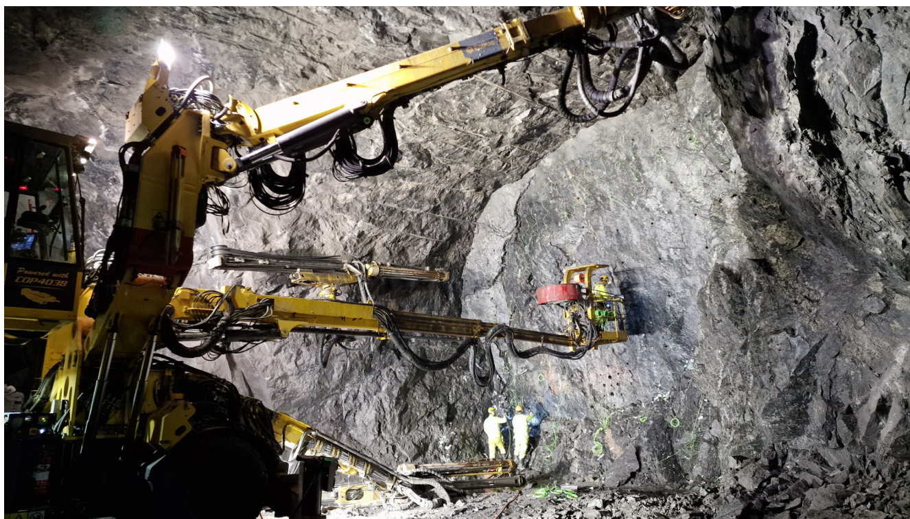
Tunnellarbeten för nya tunnelbanan i Högdalen.
